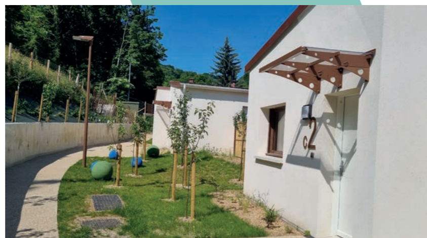
Résidence Simone Veil à Amfreville-la-Mivoie (76) – LE FOYER STEPHANAIS
